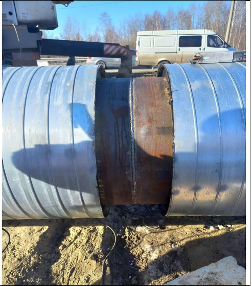
Ведутся работы по изготовлению металлоконструкций для ремонта ж/б опор
